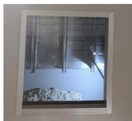
コンクリート破断の跡と、 原子爆弾の爆風で抜け落ちた 屋根の一部
